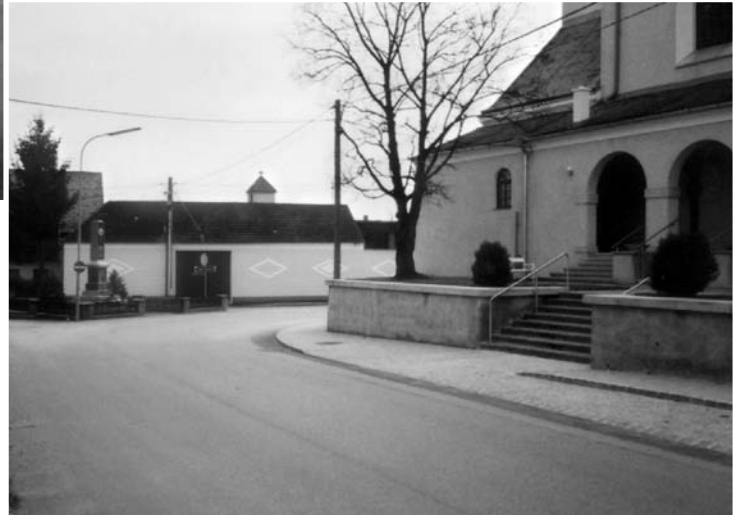
Neuer Gehsteig mit PKW-Abstellflächen an der Kirchen-Ostseite
