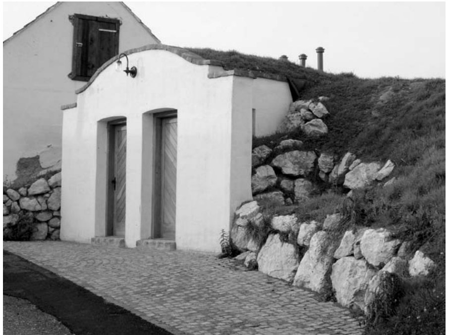
Neu errichtete WC-Anlage in der Kellergasse Pfandnerweg
