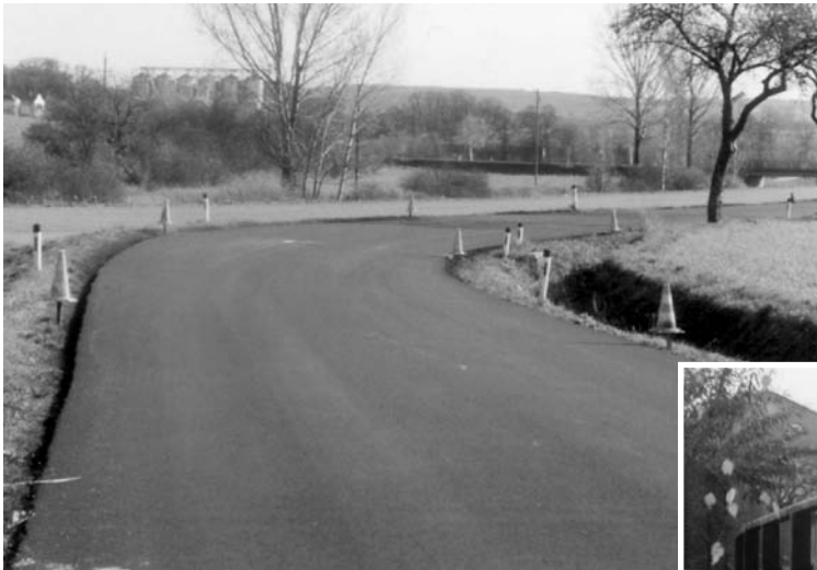
Neu asphaltierter Abschnitt auf der Straße in Richtung Wilfersdorf
