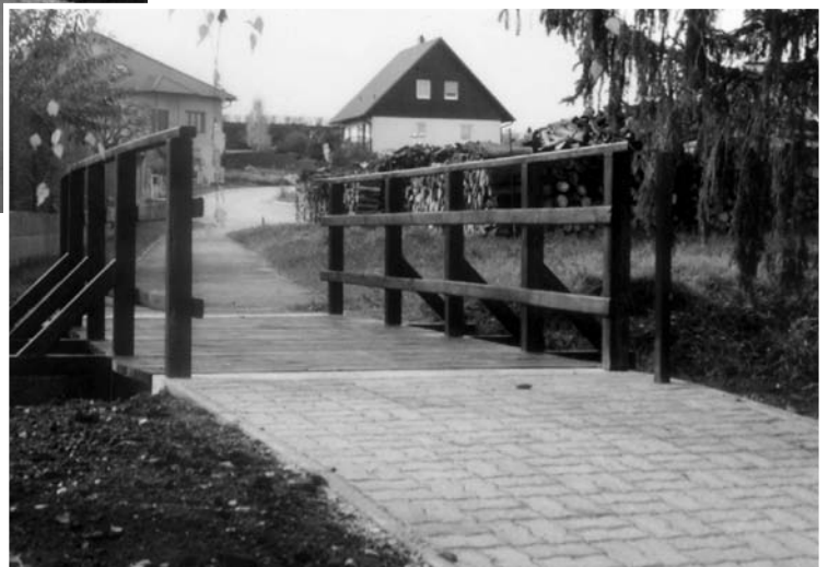
Neu errichtete Fußgänger- u. Radfahrerbrücke über den Lißlgraben
