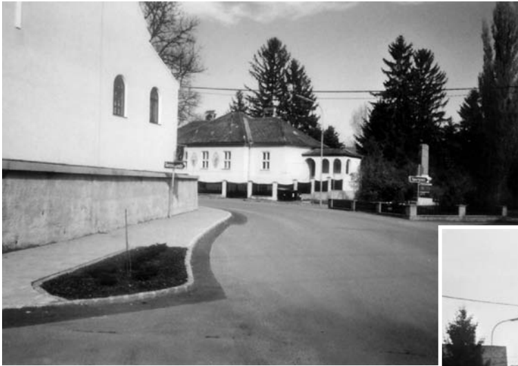
Neu angelegter Gehsteig an der Kirchen-Südseite
