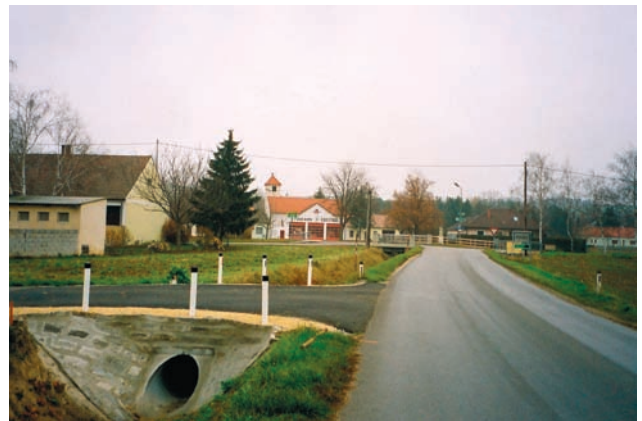
Neuerrichtung der „Friedhofbrücke“ – Foto: Matth. Schöfbeck
