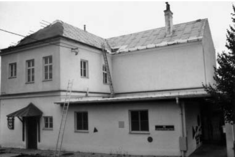
Dacherneuerung am ehemaligen Schulgebäude
