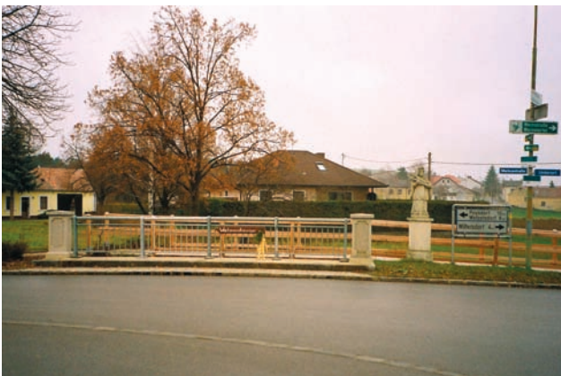
Neuerrichtung der Fußgängerbrücke – Foto: Matth. Schöfbeck
