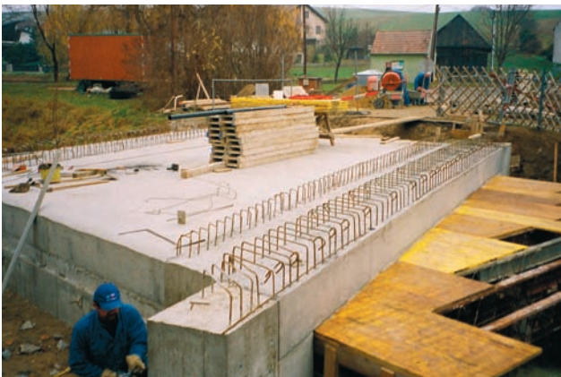
Neuerrichtung der „Sportplatzbrücke“ – Foto: Matth. Schöfbeck
