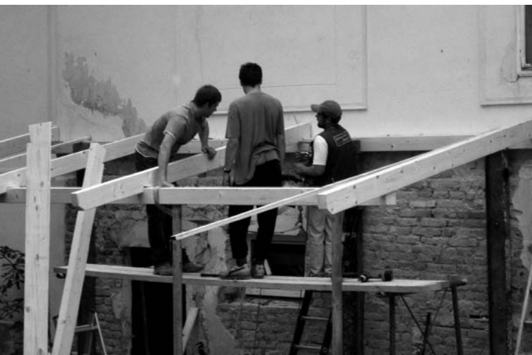
Neubau des Pfarrhofvordaches
