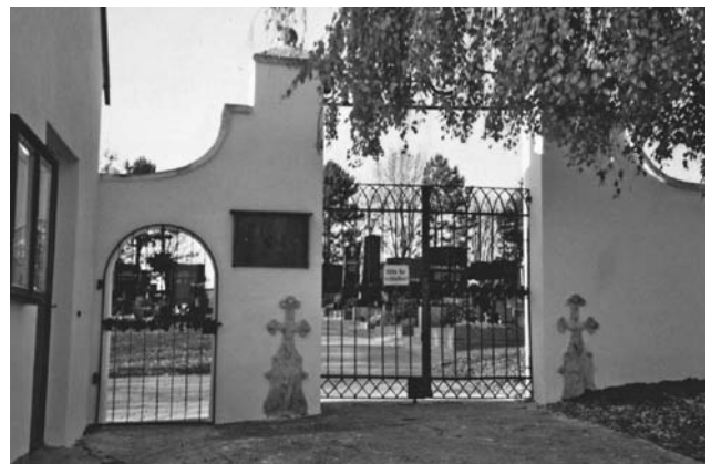
Sanierte Friedhofsmauer beim Eingangsbereich
