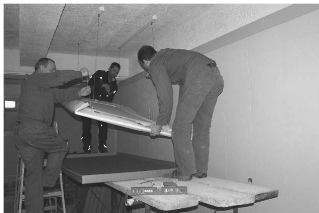
Montage der Akustikelemente an der Decke
