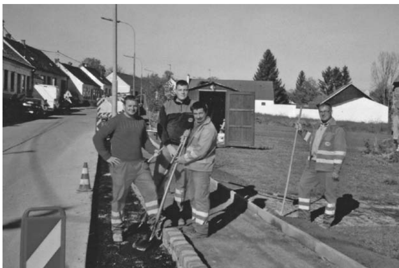
Vollständige Erneuerung des Gehsteiges im Oberort
