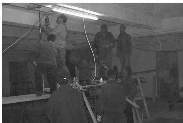
Vorarbeiten zur Montage der Akustikelemente an der Decke
