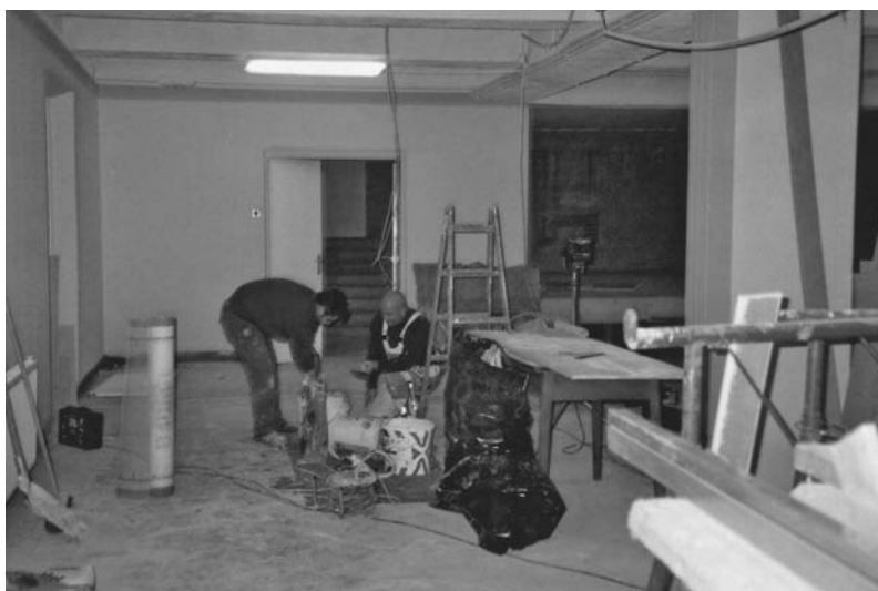
Umbau und Sanierung der Unterkirche
