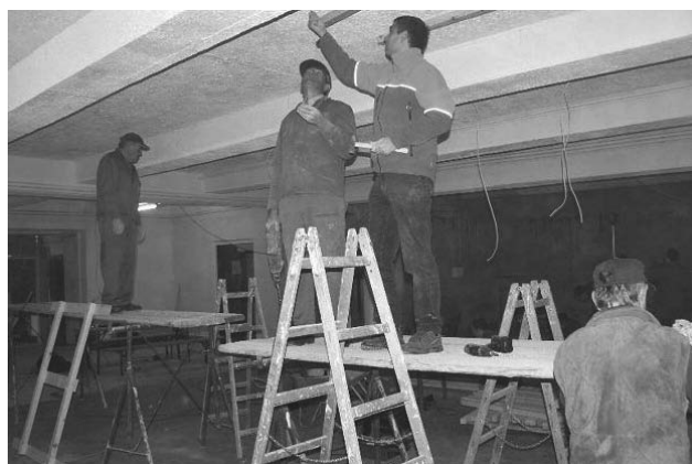
Vorarbeiten zur Montage der Akustikelemente an der Decke
