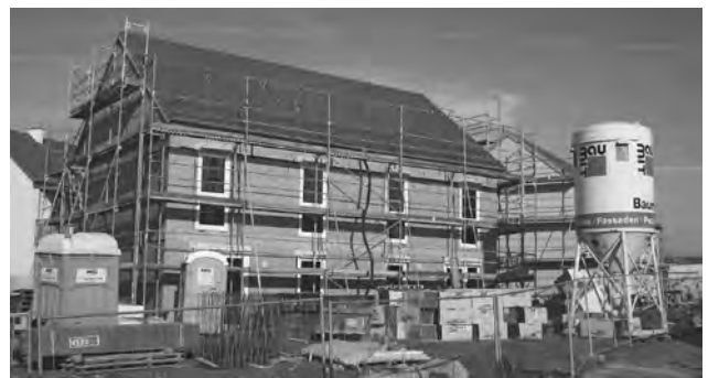
Rohbau eines Reihenhauses
