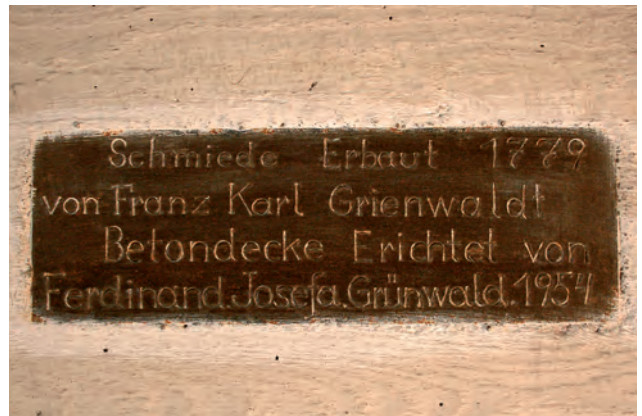
Inskriptentafel in der Betondecke der Schmiedewerkstatt
