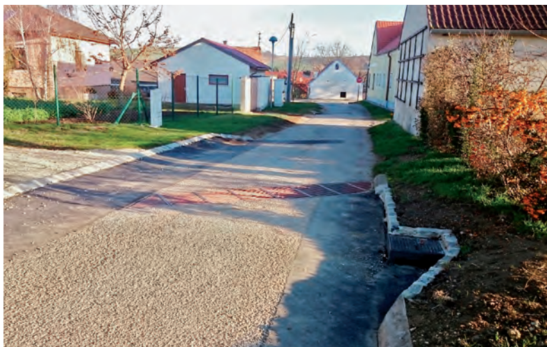
„Froschmäuler“ zur besseren Regenwasserableitung im Unterort
