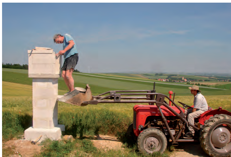
Der Rohbau entsteht.
