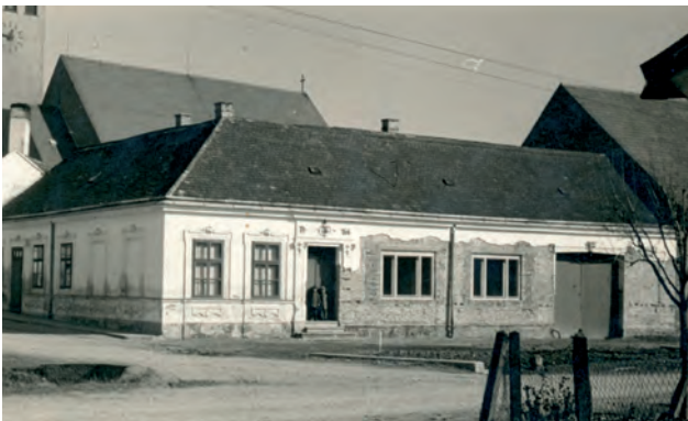
Im Umbau befindlicher Wohntrakt am heutigen Marktweg
