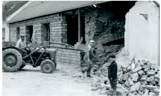
Neubau der Bäckerei sowie Abbruch des alten Backofens
