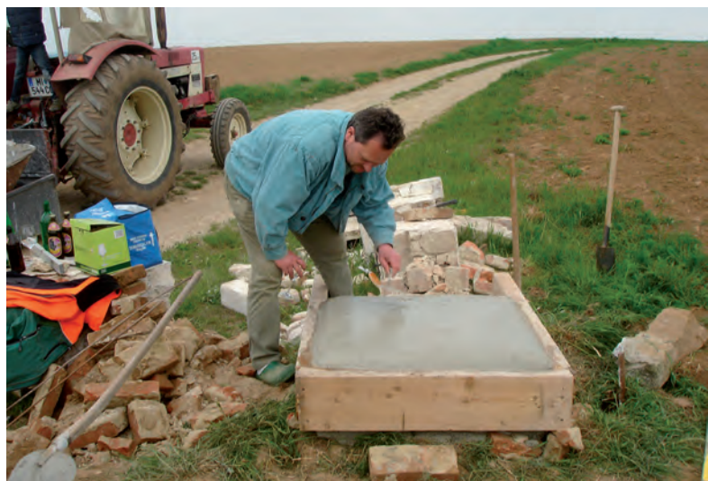
Betonieren des Sockels für das neue Weinstockmarterl
