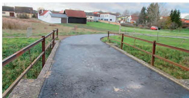
Neue Asphaltdecke auf der Bachbrücke des Gassenbrunnweges
