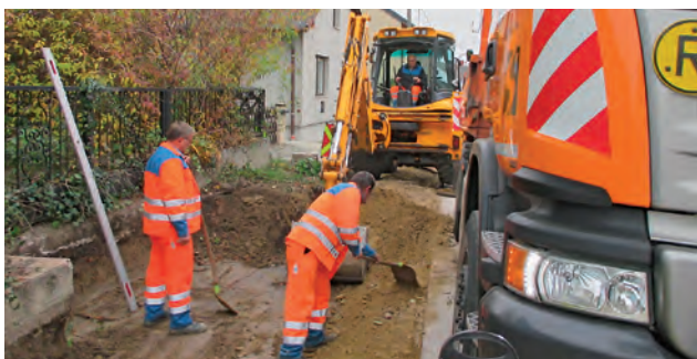
Vollständige Erneuerung des Gehsteiges im Oberort
