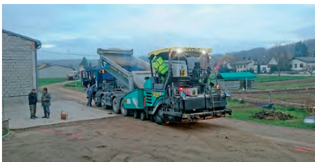
Aufbringen der neuen Asphaltdecke am Gassenbrunnweg
