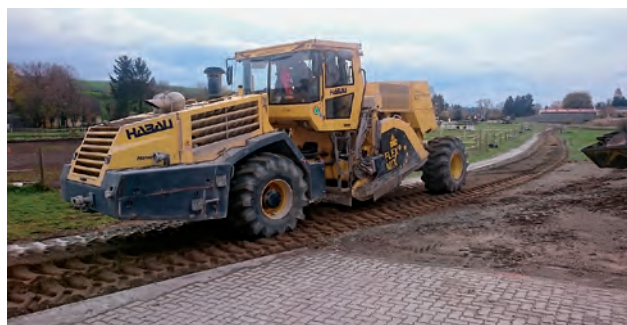
Vorbereiten des Gassenbrunnweges für die neue Asphaltdecke
