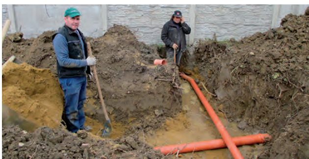
Wasserzulauf-Erneuerung für Eisteich und Löschwasserbecken
