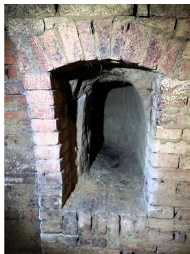
Das Loch in der Kellerröhre führt zu einem kleinen Erdkeller, der als Lagerungskeller für Weinflaschen genutzt wird. Es ist aber auch möglich, dass sich in Kriegszeiten die Bewohner hier drinnen aufgehalten haben, und das Loch mit einer Ziegelmauer mit Kalkmörtel zugemauert war.
